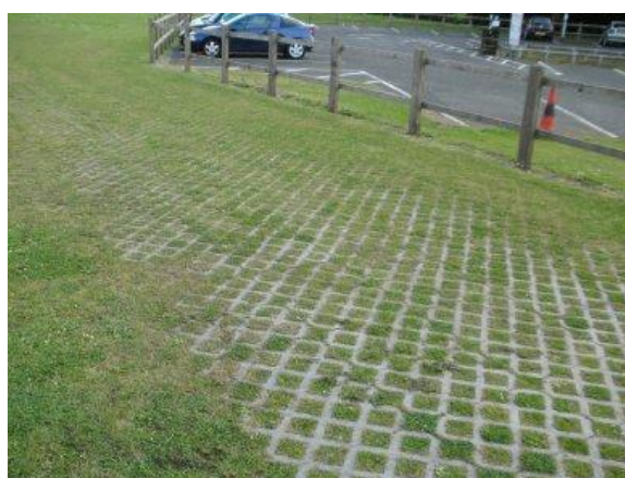
Exemple de revêtement perméable et carrossable
