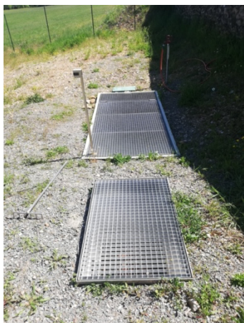
Dégrilleur au 1 er plan en très bon état. RAS. Bassin de chasse au 2 ème plan avec compteur de bâchées en très bon état également. RAS
