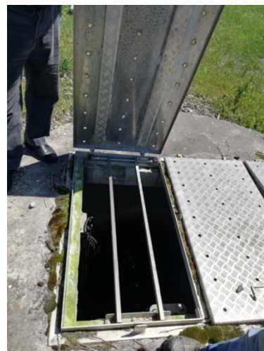
PR1 et PR2 équipés de barres stop-chute.
