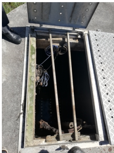
PR1 et PR2 équipés de barres stop-chute.
