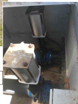
Vannes pneumatiques
